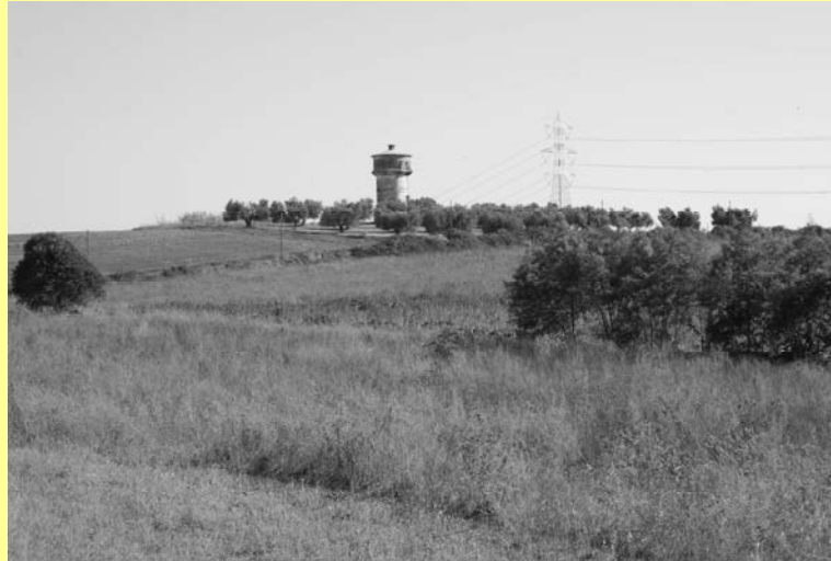
Serbatoio dell'acquedotto di Montebello realizzato dall'Ente Maremma
