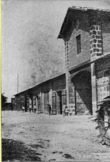
Deposito macchine agricole
